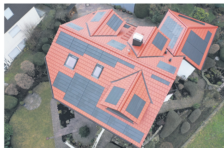
Dach mit integrierten Solar-Modulen. Foto: PR
