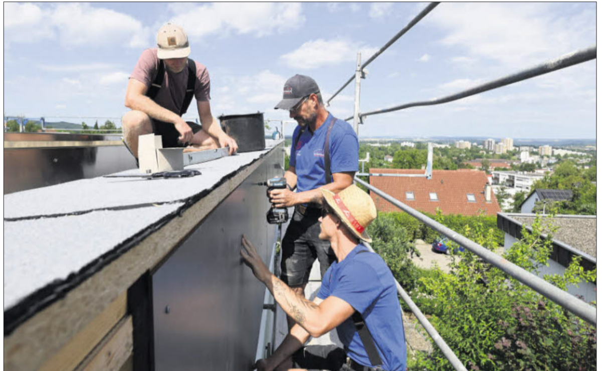
Hoch über Reutlingen sind Dachdecker extremen Temperaturen fast schutzlos ausgesetzt. Wenn dann noch Dachpappe mit einem Gasbrenner verschweißt werden muss, kommt die Hitze von oben und unten.
