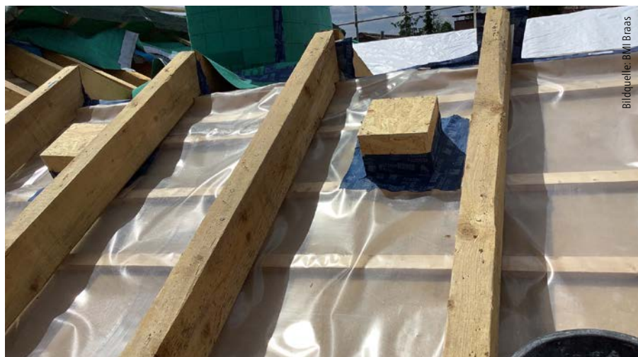
Die integrierten Halogenstrahler wurden luftdichtend umhaust.
