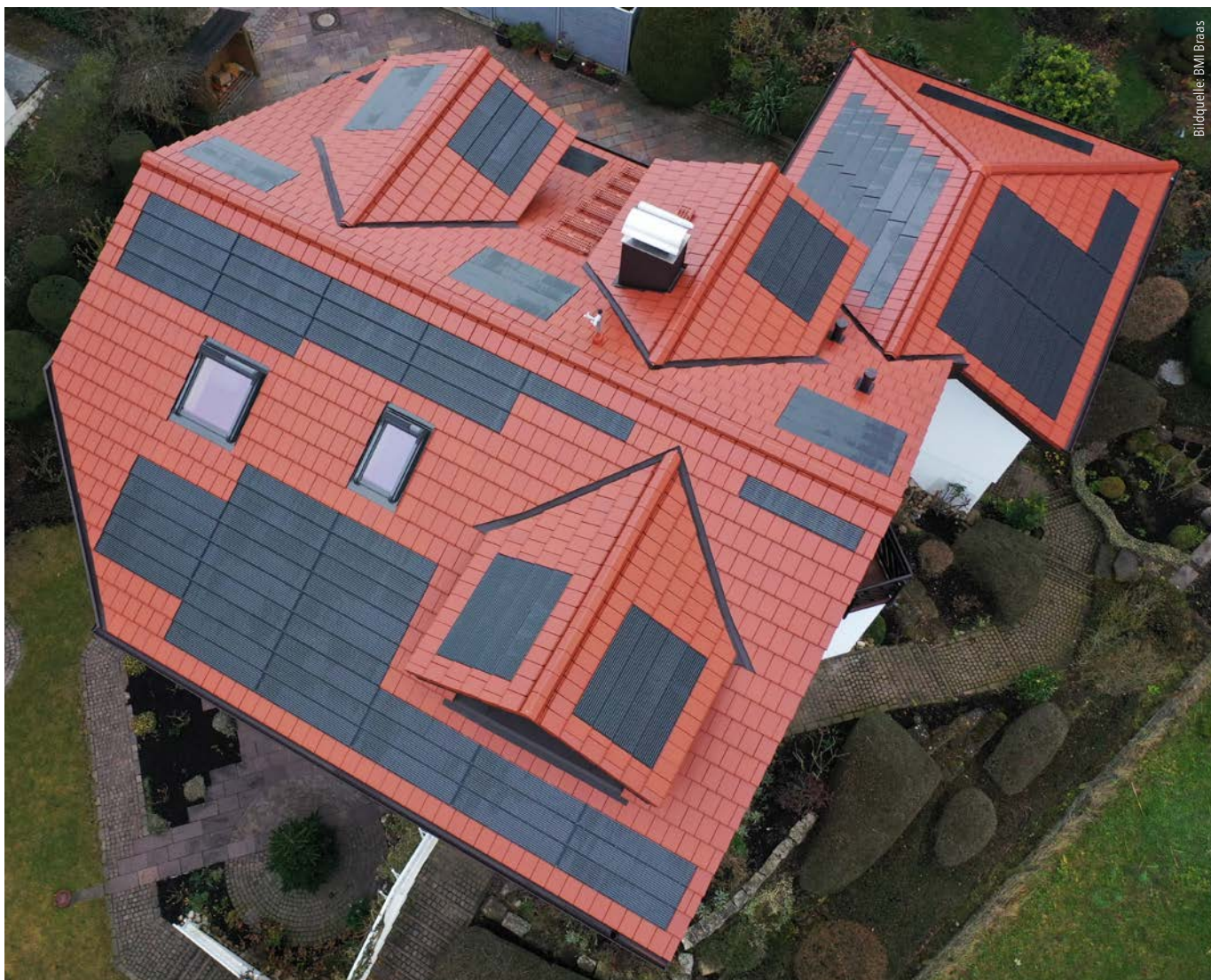
Durch die Planung von Dachdeckermeister Schwarzbach und geschickte Einteilung konnten mehr Module auf dem Dach platziert werden als ursprünglich geplant.
