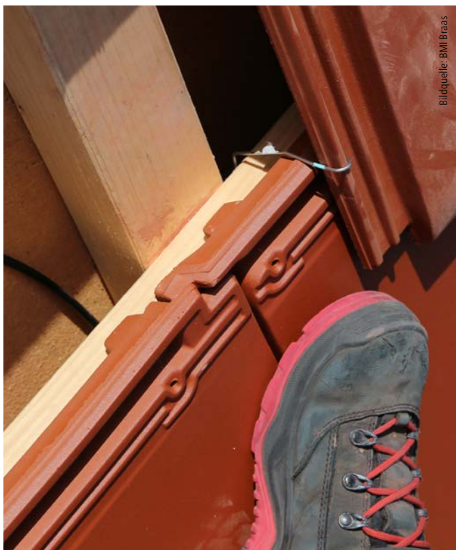
Die Dachziegel werden mit einem abgestimmten Clip lagesicher gegen Windsog gehalten.
