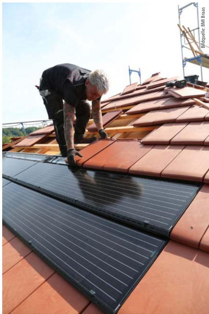
Die Decklänge der Module ist der Decklänge der Ziegel angepasst.
