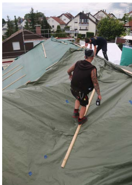
Widrige Wetterumstände: Etliche Stunden Arbeit sind Sichern der Dachkonstruktion durch Abplanen geschuldet.
