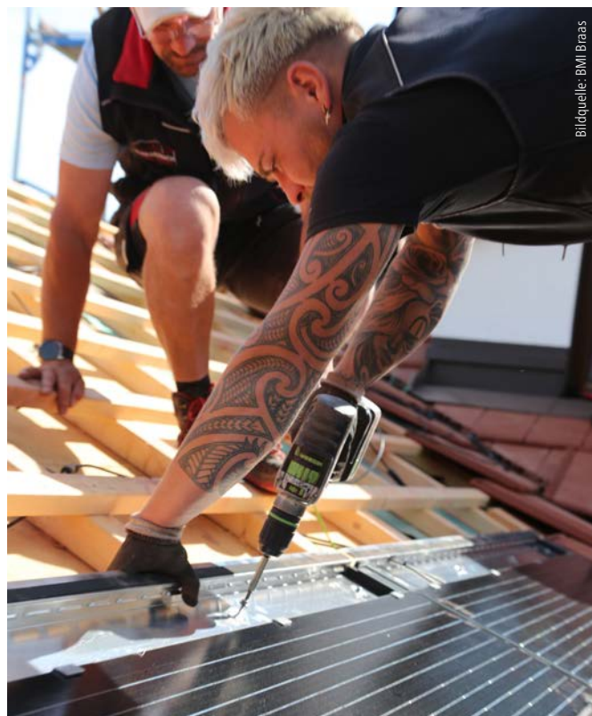
Die Module werden im Kopfbereich mit den beiliegenden Spenglerschrauben gegen Windsog gesichert.
