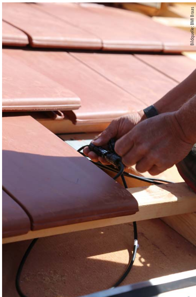
Die Kabel der einzelnen Module werden verpolungssicher miteinander verbunden.
