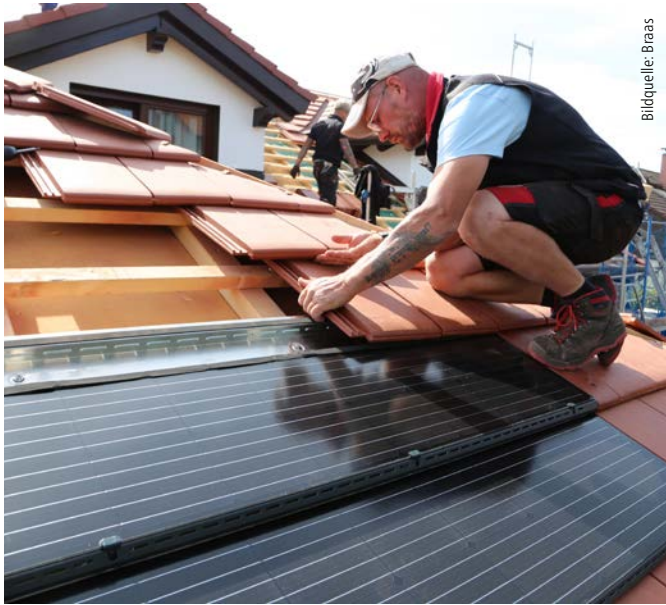
Dachdecker Andreas bei der Montage von PV-Modulen
