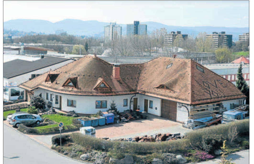
Eine imposante Dachlandschaft prägt das Firmengebäude in der Lembergstraße. FOTOS: TRINKHAUS
